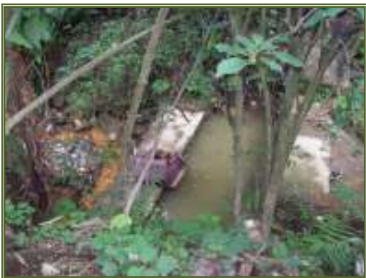
Disposición inadecuada de escombros y residuos sólidos
